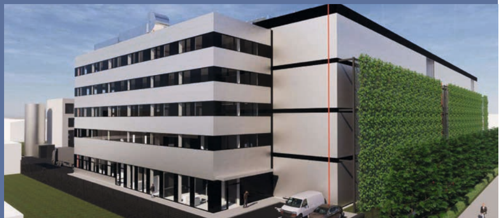
→ Office DE Datacenter FR11 Frankfurt Voiles de plafond/F0
