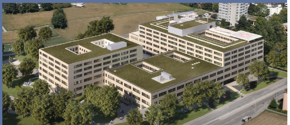
→ Health CH PZ hôpital Limmattal Plafond acoustique/F0
