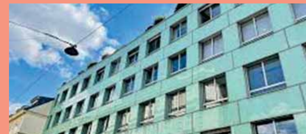
→ Office AT Bürogebäude Floragasse Wien baffle
