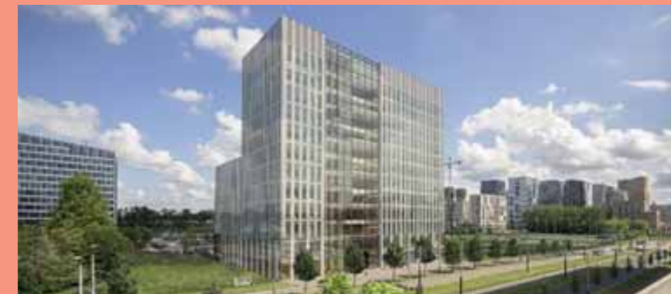
→ Education NLD Onderzoeksgebouw VU De Boelelaan sufit chłodzący
