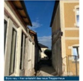
Büro neu - hier entsteht die neue Treppenhalle
