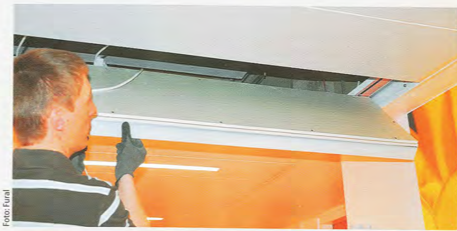
Wartungsfreundlich. Dank der Abklapp-Schiebefunktion können die revisionsfreundlichen Brandschutz-Kassetten einfach geöffnet werden. Die Decke kann mit Friesen bis zu 3,80 m frei gespannt werden.
