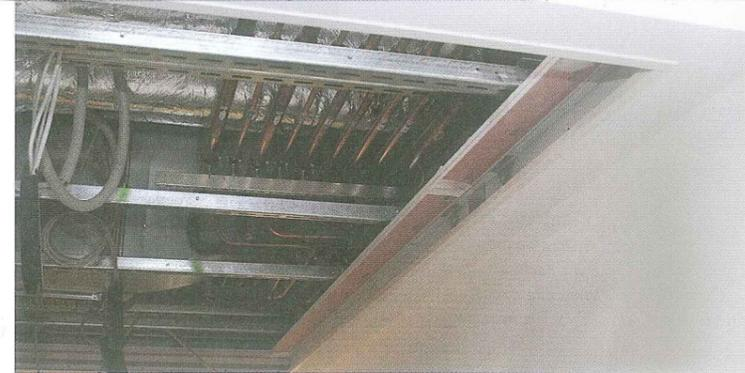
**Die Vorteile einer Brandschutzdecke aus Metall liegen in diesen Einsatzbereichen auf der Hand. Durch den modulartigen Aufbau der Decke ist jede einzelne Kassette zu öffnen, notwendige Arbeiten im Deckenhohlraum sind somit bequem durchführbar.**
