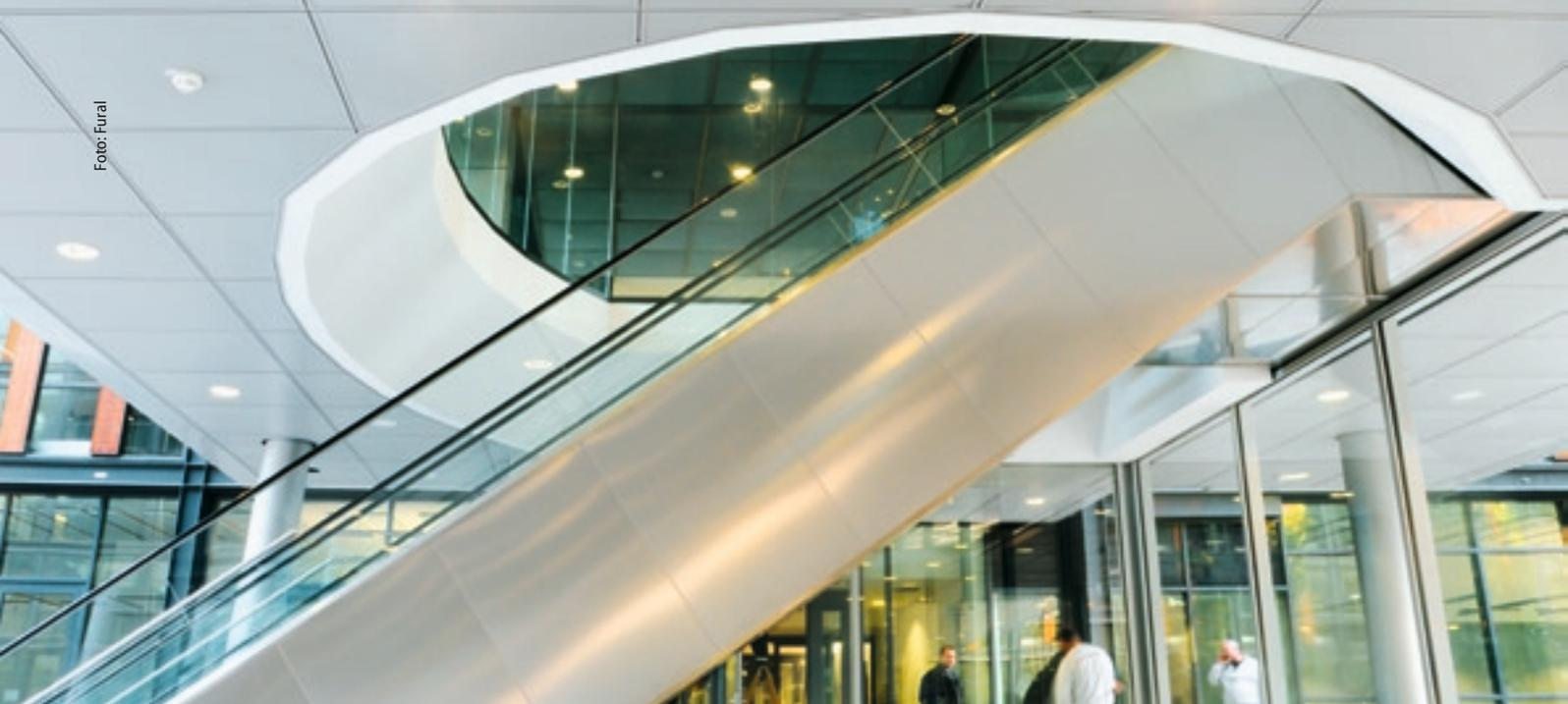
**Mit Ecken und Kanten.** Den Durchstoß der Rolltreppe im Eingangsbereich umgibt eine aufwendige GK-Verkleidung. Sie hat die Geometrie eines polygonalen Kegelstumpfs, der Durchmesser beträgt 7,20 m.
