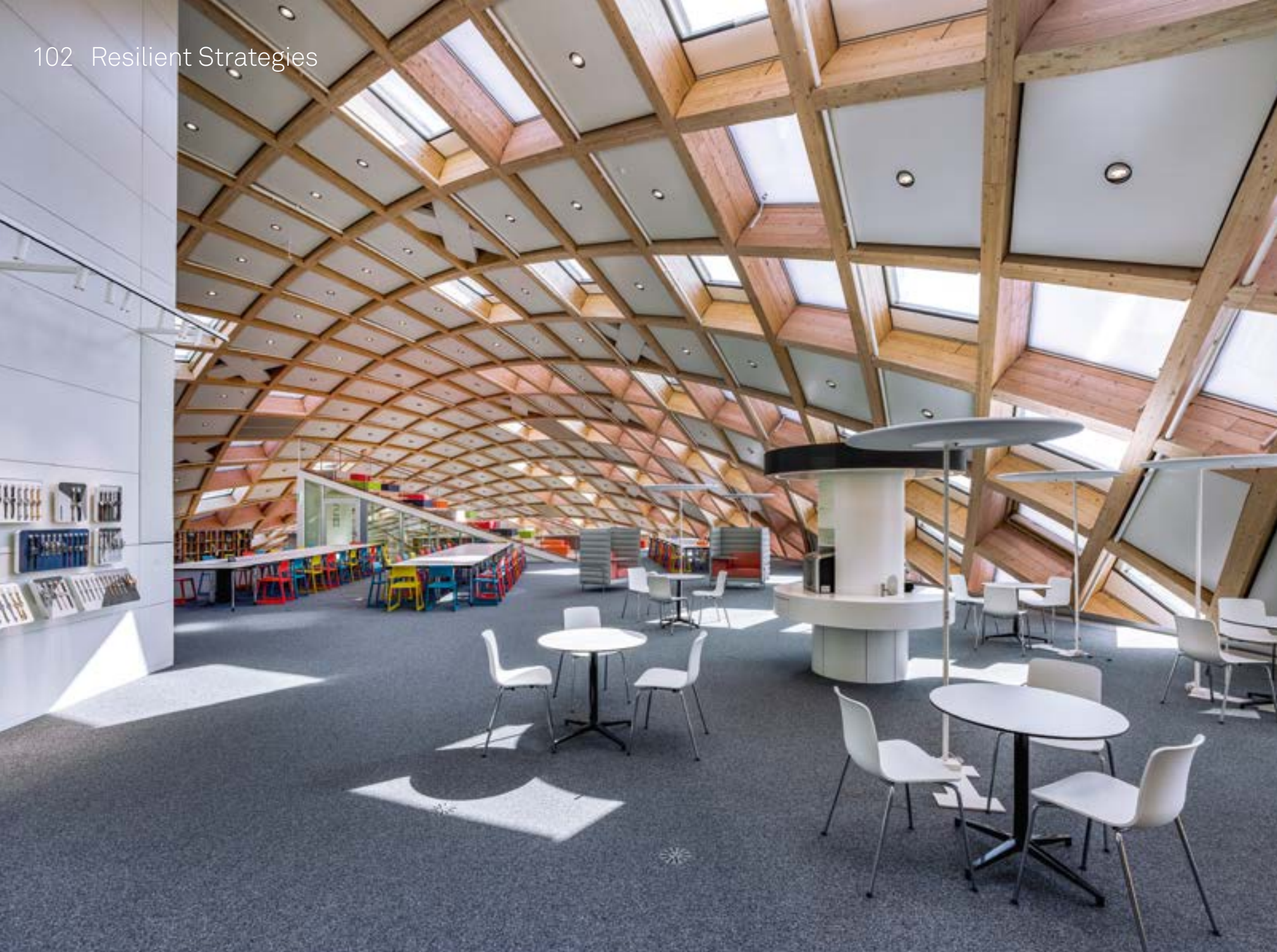
Durch die transparenten, aus vier Glasscheiben bestehenden Füllungen fließt natürliches Licht in das Gebäude. Natural light flows into the building through transparent elements that consist of four panes of glass.
